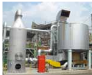
< 工場排ガスの臭気対策（脱臭炉） >
