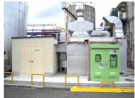
触媒燃焼脱臭装置（2基目）
