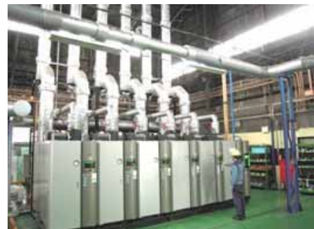
ボイラー燃料を灯油・重油から天然ガスへ変換
